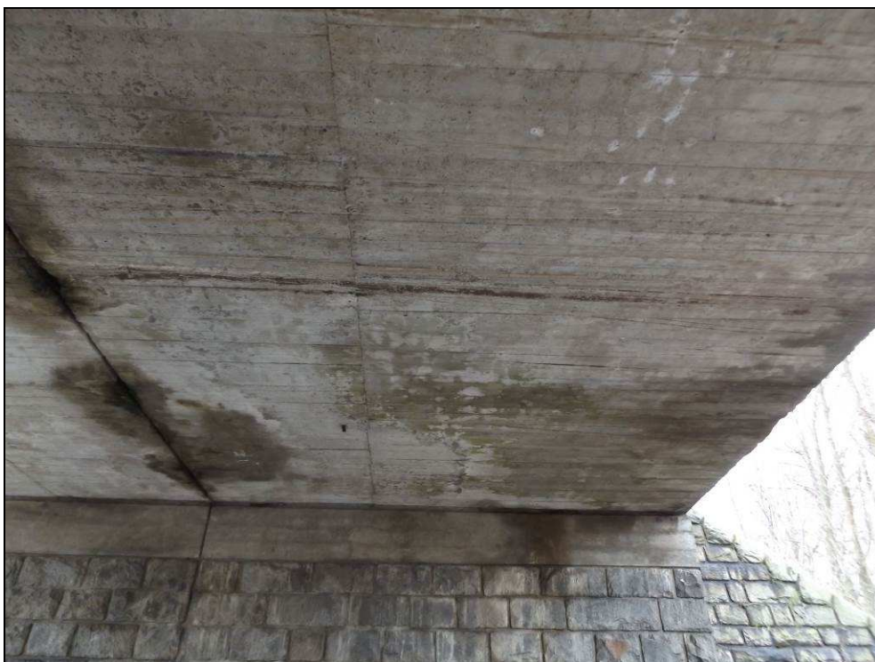
Obr. č. 6 - pohled na vybranou část NK. Levá část fotografie zachycuje průsaky vody dilatační spárou.
