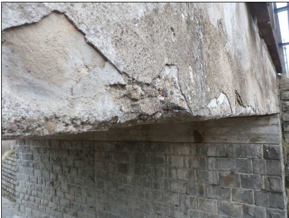
Obr. č. 10 - detailní pohled na opady omítky na čelech NK.
