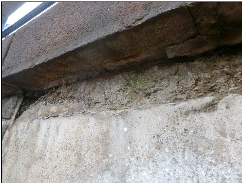
Obr. č. 9 - detailní pohled na degradovaný beton v oblasti kontaktu s římsou objektu.
