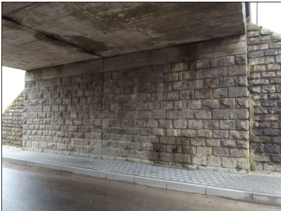
Obr. č. 7 - pohled na vybranou opěru objektu. V pravé části fotografie jsou zachyceny průsaky vody skrze spárování.
