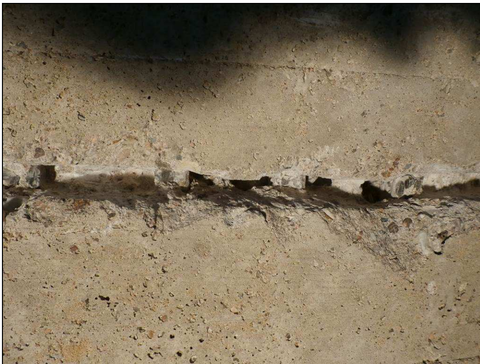
Obr. č. 8 - detailní pohled na sondu do spodního líce NK pro ověření výztuže - ocelová tvarovaná výztuž typu „ROXOR“ 10512 s rozměrem tyče D= 35 mm.
